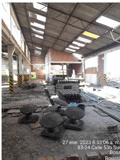
Ilustración 35. Incumplimiento de protocolo de manejo de asbesto- No se evidencia material embalado ni etiquetado. Fecha: 26 y 27-01-2023.
