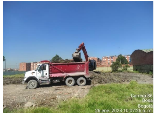
Ilustración 33. Cargue de descapote. Fecha: 26-01-2023.
