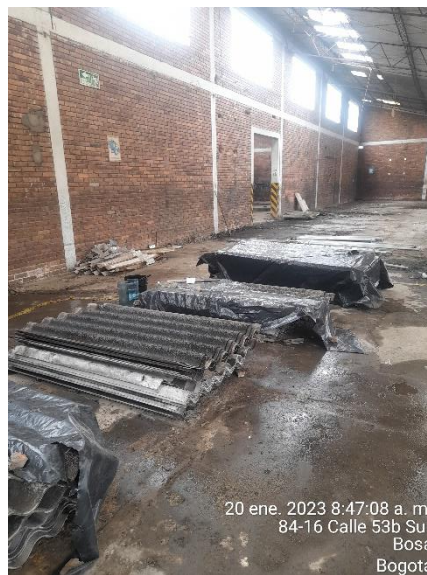
Ilustración 19. Deficiencia en el embalaje de tejas con asbesto.
