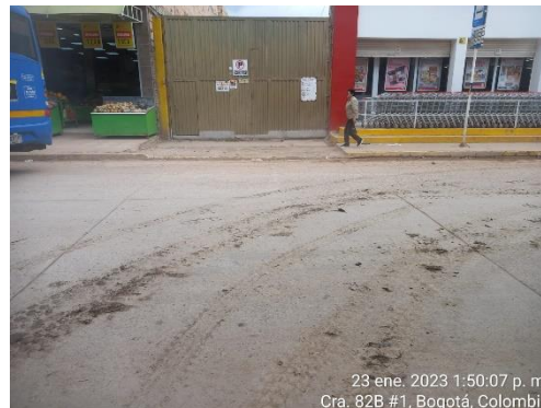
Ilustración 26. Presencia de barro en la vía de acceso a obra- se solicita implementar sistema de lavado de llantas. Fecha: 23-01-2023.
