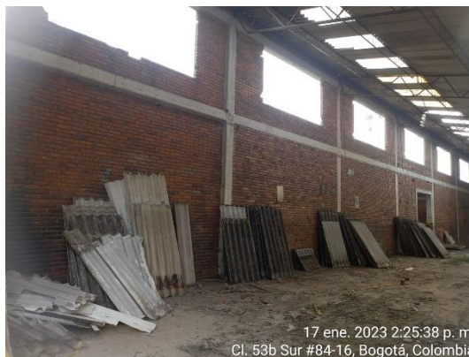
Ilustración 9. Acopio de tejas sin cumplir las condiciones establecidas en el protocolo para manejo de asbesto. Fecha: 17-01-2023.
