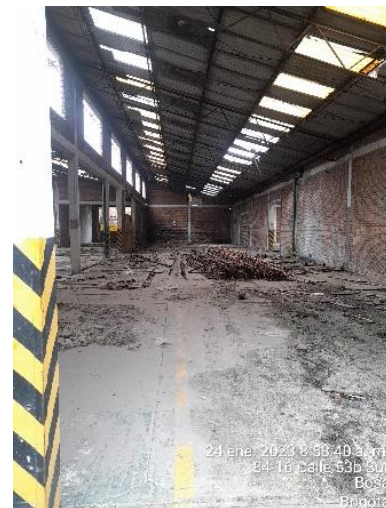
Ilustración 28. Acopios de RCD's- Se solicita señalizar y proteger según corresponda.
