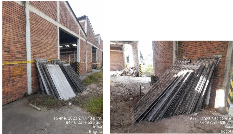
Ilustración 7. Acopio de teja sin humedecer y sin empacar incumpliendo con el protocolo de manejo de asbesto. Fecha :16-01-2023.
