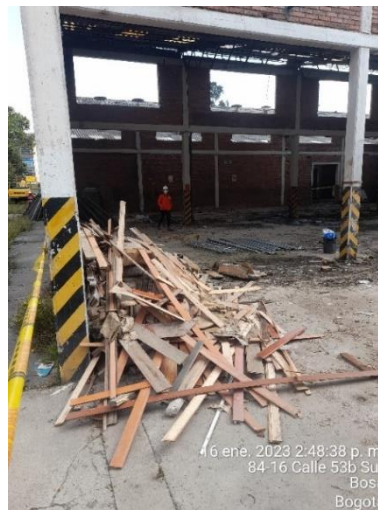
Ilustración 8. Acopio de madera sin proteger, señalizar y delimitar. Fecha: 16-01-2023.
