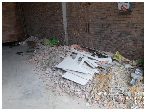
Ilustración 5. Acopio de RCD's- sin delimitar, señalizar y proteger. 27-12-2023.
