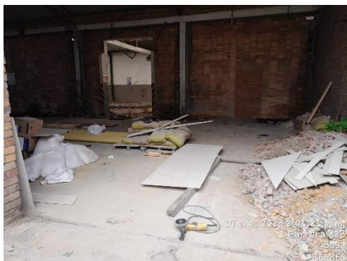
Ilustración 11. Continúa la presencia de acopios mezclando los diferentes RCD's y acopios de materia prima incumpliendo los parámetros del PMA. Fecha: 17-01-2023
