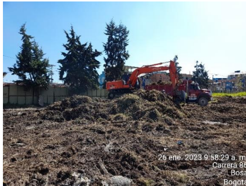
Ilustración 33. Cargue de descapote. Fecha: 26-01-2023.
