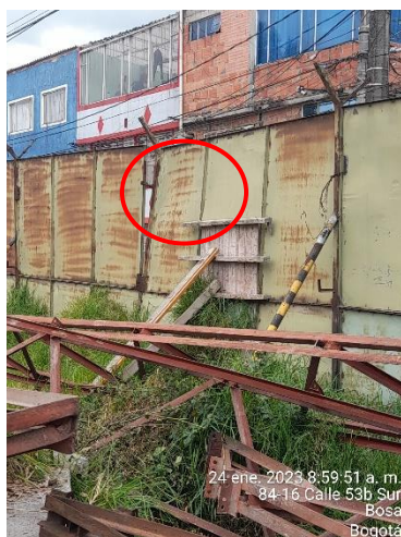
Ilustración 30. Se solicita realizar mantenimiento a tramos de cerramiento los cuales se encuentran deteriorados. Fecha:24-01-2023.
