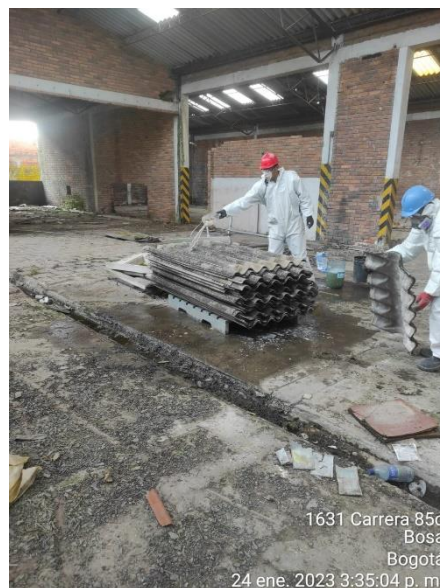
Ilustración 23. Adición de agua jabonosa a tejas.
