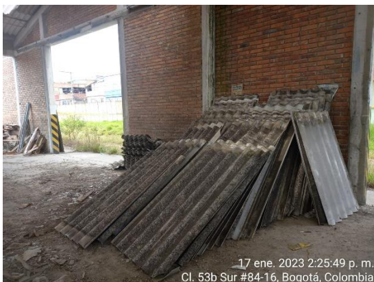
Ilustración 9. Acopio de tejas sin cumplir las condiciones establecidas en el protocolo para manejo de asbesto. Fecha: 17-01-2023.
