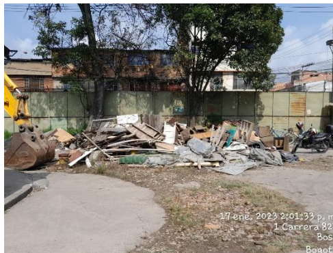
Ilustración 11. Continúa la presencia de acopios mezclando los diferentes RCD's y acopios de materia prima incumpliendo los parámetros del PMA. Fecha: 17-01-2023
