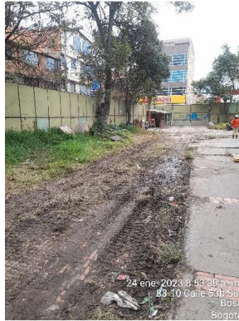
Ilustración 27. Presencia de barro al interior de la obra el cual es arrastrado en las llantas de los vehículos. Fecha: 24-01-2023.
