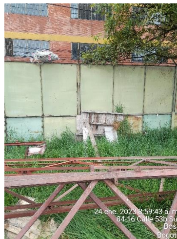
Ilustración 30. Se solicita realizar mantenimiento a tramos de cerramiento los cuales se encuentran deteriorados. Fecha:24-01-2023.
