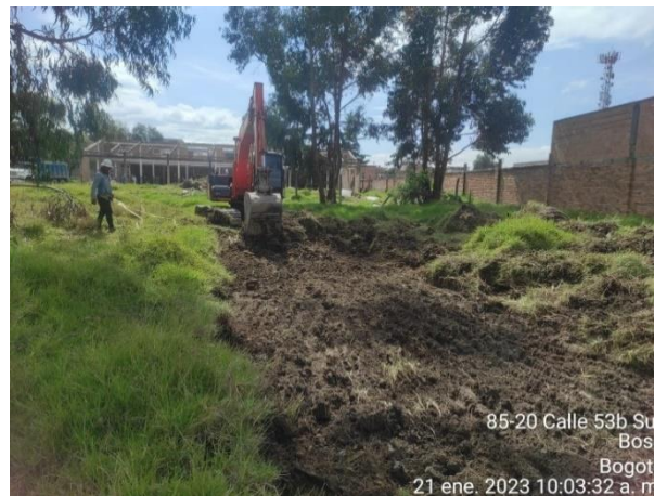
Ilustración 25. Início de descapote.
