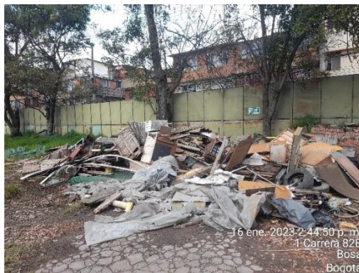
Ilustración 6. Acopio de RCD's en el cual se evidencia que no se están segregando por tipo de residuo.
